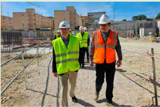
El conseller de Sanitat de la Generalitat, Marciano Gómez, en las obras de ampliación del Hospital Marina Baixa
